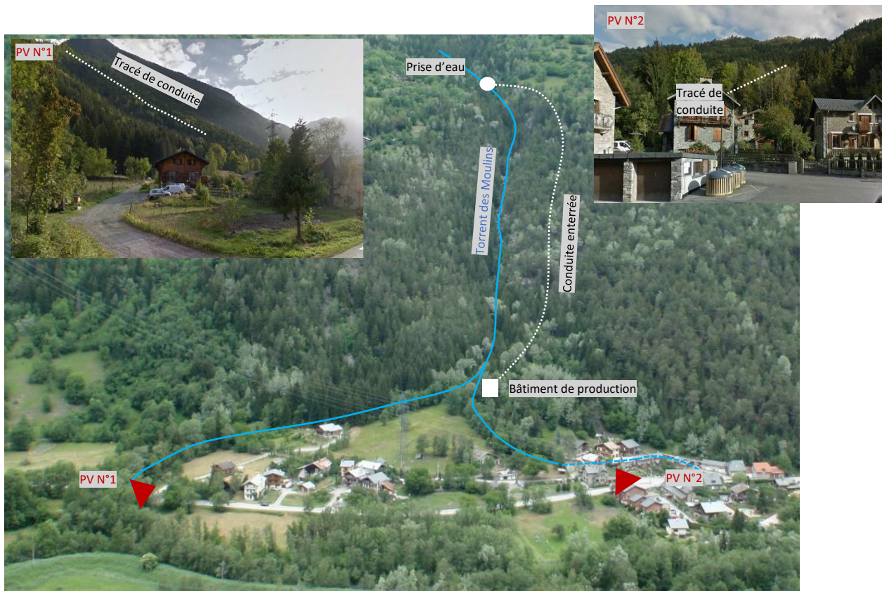
Perception de la conduite enterrée depuis le hameau de Viclaire
